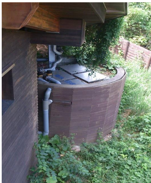
圖 3 北投圖書館的雨水回收槽 (圖片來源：陳俊儒拍攝 2014 年 9 月 14 日)
